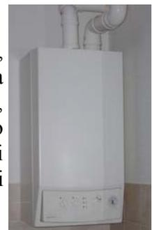
La caldaia del tipo a doppio uso produrrà anche acqua calda per le apparecchiature sanitarie.
