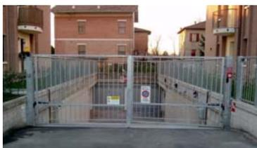
Il cancello dell'accesso carraio, verrà realizzato in ferro zincato e preverniciato a semplice disegno, con apertura del tipo a scorrere ad una partita, completo di motorizzazione elettrica con comando a distanza (1 ogni alloggio).
