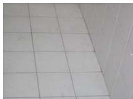
Tutti i locali della zona giorno saranno pavimentati con mattonelle di ceramica monocottura di prima scelta nel formato di cm. 30x30, o similare, del prezzo netto di acquisto di € 10,00 il m<sup>2</sup>, posati a correre con fughe accostate.
